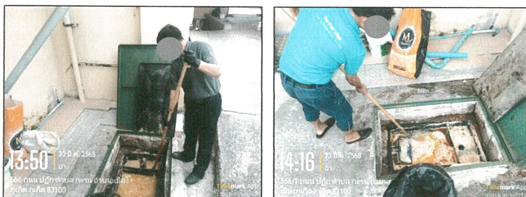
รูปภาพที่ 2.13 การตัดกากไขมัน
